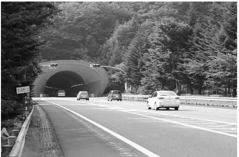
関越自動車道 関越トンネル
