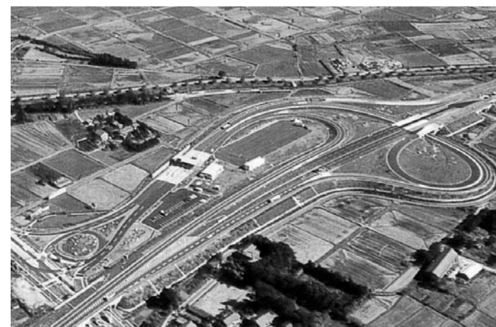
磐越自動車道 (安田料金所)
