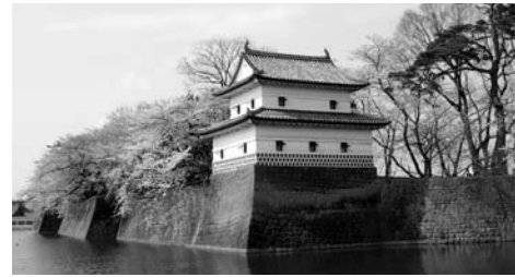
新発田城旧二の丸隅櫓 (新発田市)
