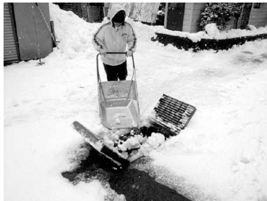
流雪溝に雪をすてている様子(魚沼市)
