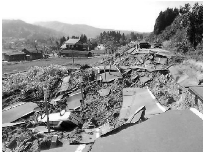
くずれ落ちた道路
