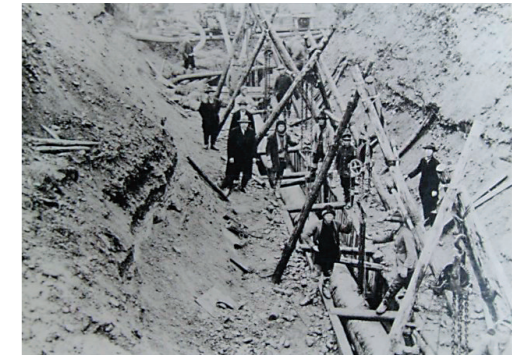
上水道の工事
