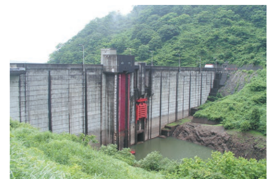
②刈谷田川ダム（長岡市栃堀）
