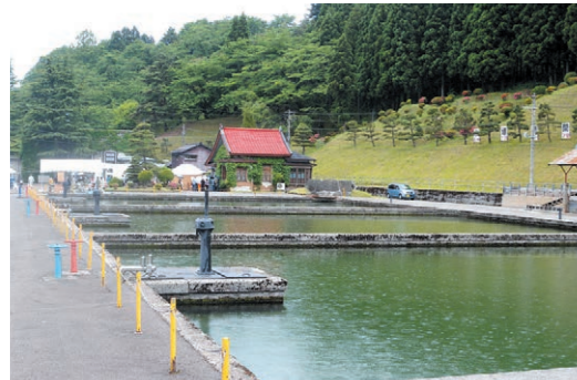
かん速ろ過池
