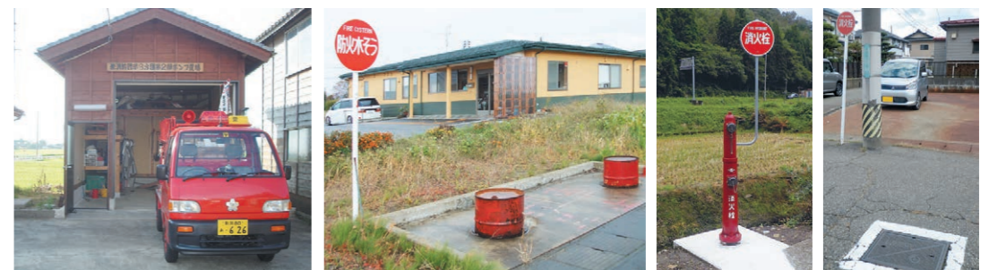
積載車とポンプ置場
