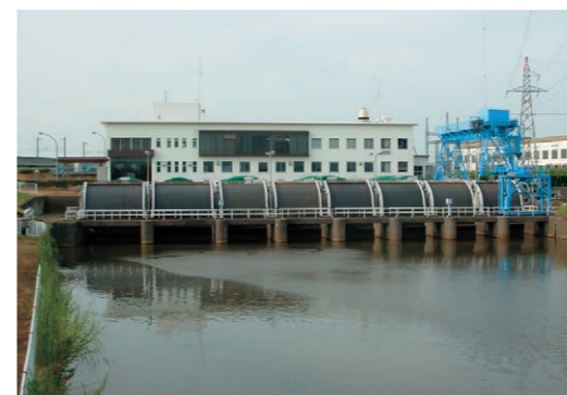
①刈谷田川右岸排水機場（今井）
