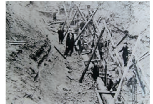
上水道の工事
