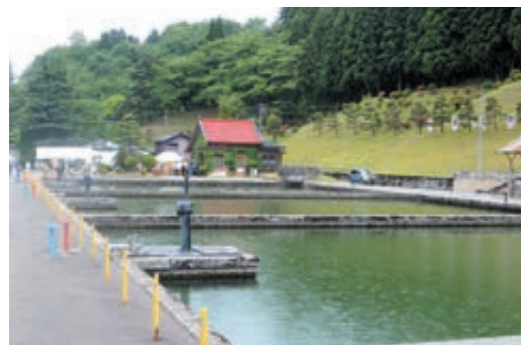
かん速ろ過池
