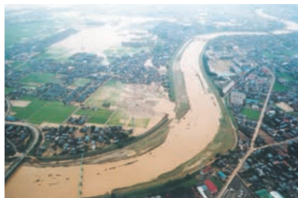
上空から見た五十嵐川と浸水した市街地（7月14日）
