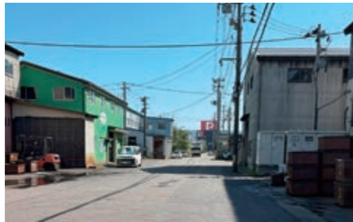
③ 工場が多く集まっている所 (金子新田工場団地)
