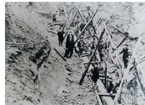
上水道の工事
