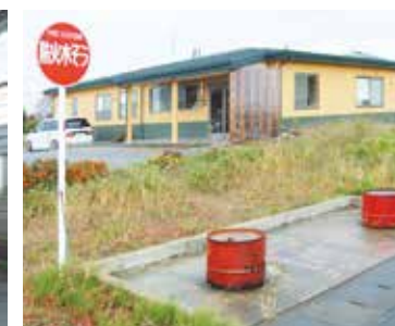
防火水槽 (この下に水がためてある)
