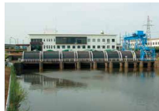
①刈谷田川右岸排水機場（今井）
