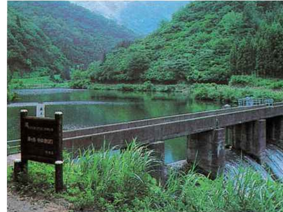
第2ダム(第2貯水池)
