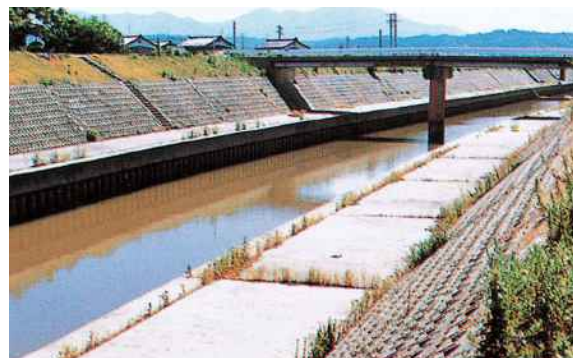
工事後の下条川
