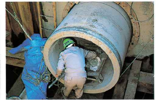
ほんかん 下水管（本管）の工事のようす
