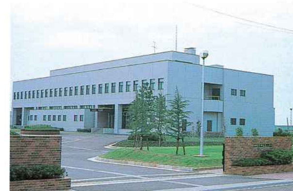
じょうか 加茂市浄化センター（加茂新田）
