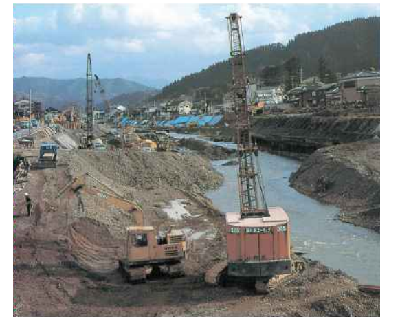
1983 (昭和58) 年ころの工事のようす (昭和橋付近)
